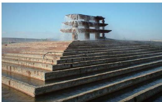
螺旋型装置：長い開水路を流下させて熱水を冷却します。適温になった場所では入浴に利用する住民も。
