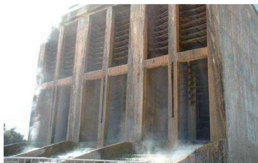
塔型装置：熱水をシャワー状に落下させ冷却します。
