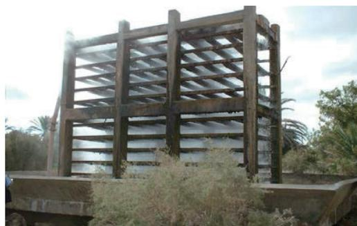
格子型装置：熱水を落下させ冷却します。日本でも温泉の冷却に類似の装置が使われています。
