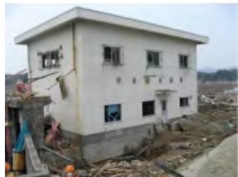
山元町：排水機場
