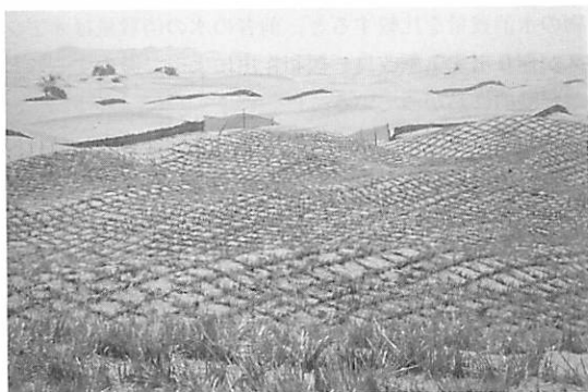
図5. タクラマカン沙漠での防風ネット、アシ防風垣、草方格。
